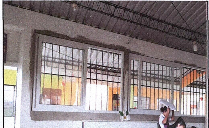
Foto 2: Finalización de mejoramiento de ventanas.
