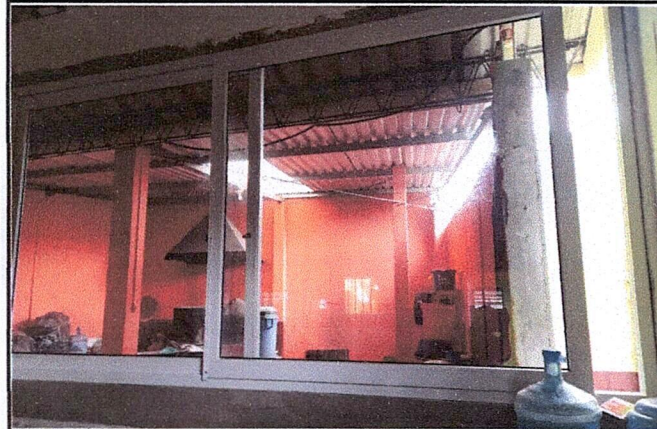
Foto 3: Finalización de mejoramiento de ventanas.
