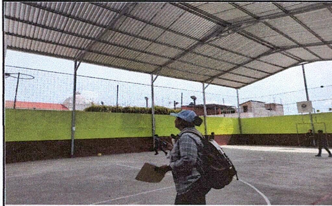
Foto 1: Finalización de mejoramiento de techo.
